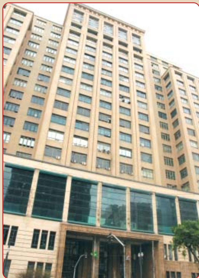
Prédio da Sede da Secretaria da Fazenda
